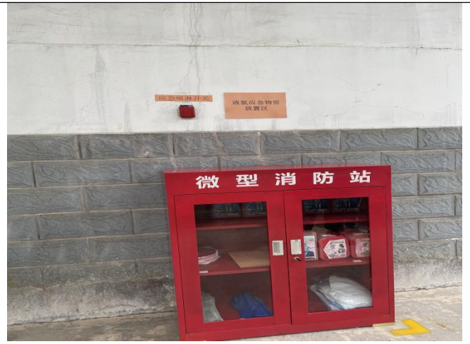
液氨微型消防站
