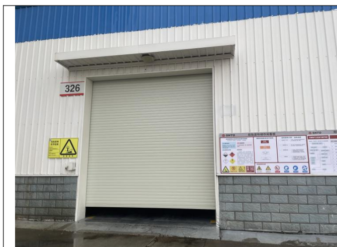
危险废物储存间和看板
